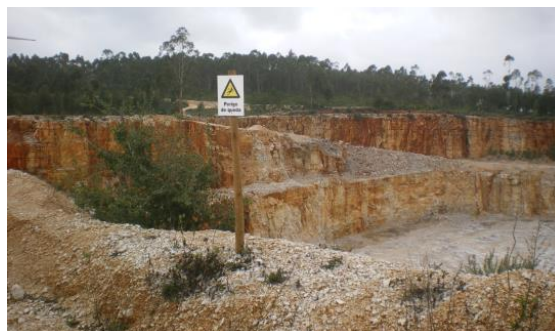
Foto 31 – Talude de proteção na bordadura da escavação e sinalização
